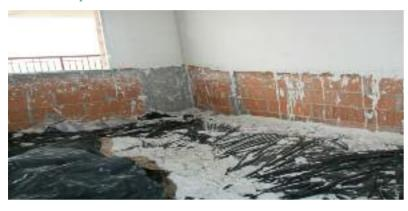
É aplicado manualmente ou por meio de projeção pneumática em paredes de alvenaria de blocos cerâmicos ou de concreto. A geração de resíduos ocorre tanto na operação de aplicação quanto no posterior nivelamento da superfície do revestimento.
