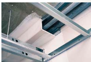
Fechamento de shaft e instalação do FGR.
