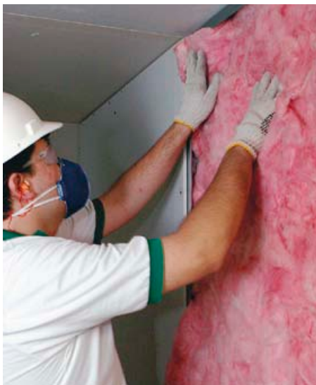
Instalação da lã de vidro. © 2008 - Banco de imagens Gypsum Drywall.
