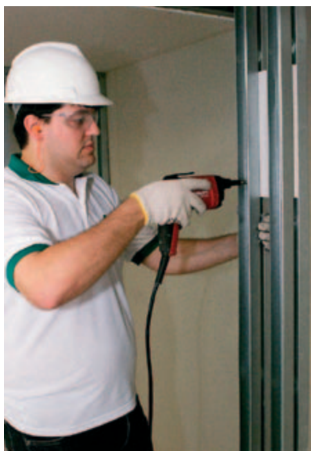
Fixação de estruturas metálicas. ©2010 - Banco de imagens Gypsum Drywall.
