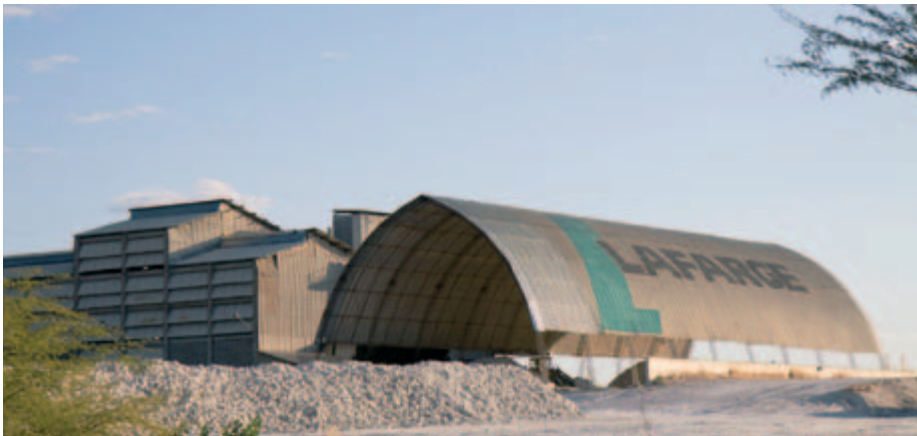
Galpão na Fábrica Gypsum em Petrolina - PE. ©2010 - Banco de imagens Gypsum Drywall.
