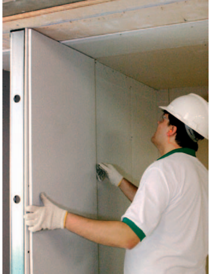
Etapa de montagem. ©2010 - Banco de imagens Gypsum Drywall.
