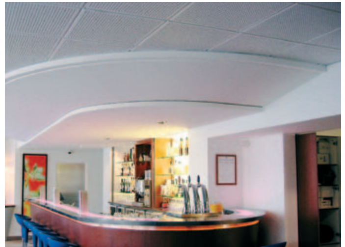
Forro estruturado GypSOM em composição com forro liso. Novotel Créteil, Paris, França. Foto: Philippe Baudet ©2004 - Banco de imagens Gypsum Drywall.
