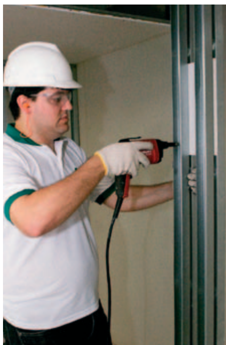
Fixação de estruturas metálicas. ©2010 - Banco de imagens Gypsum Drywall.
