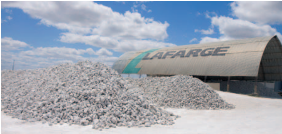
Galpão na fábrica Gypsum Drywall em Petrolina - PE. ©2010 - Banco de imagens Gypsum Drywall.
