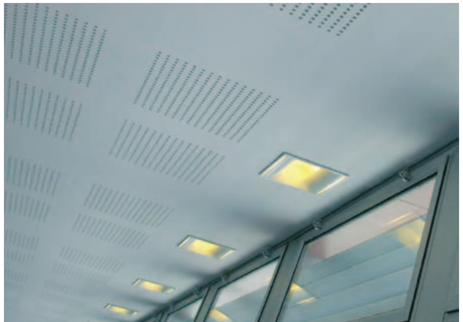
Teto com forro GypSOM. ©2009 - Banco de imagens Gypsum Drywall.
